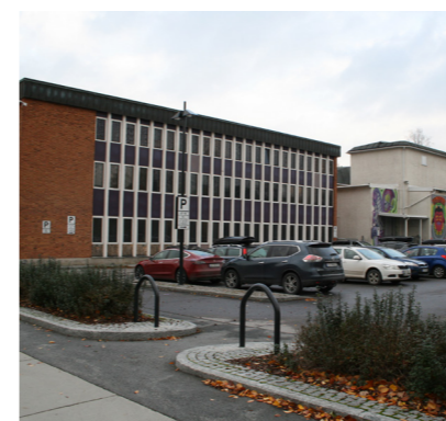
Figur 3.71. Rådhusplassen grenser mot parkering i nord
