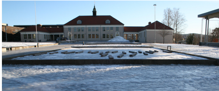
Figur 3.120. Tråkkheller gjør at vannspeilet ikke kan brukes som skøytebane
