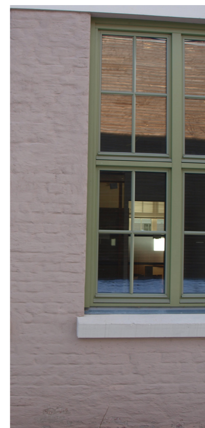
Figur 3.106. Grønne vinduskamer på skolebygget
