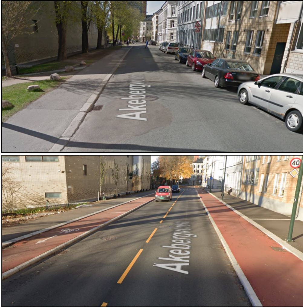
Figur 3.4: Over: Åkebergveien før oppgradering, mai 2017. Under: Åkebergveien med opphøyde sykkelfelt, november 2020. Skjerm bilde fra Google Maps [31].
