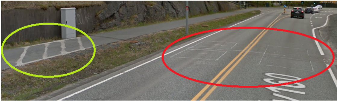
Figur 2.6: Trafikkregistreringspunkt for både motorkjøretøy og sykkeltrafikk. Fire induktive sløyfer er installert i veibanen (rød sirkel) på samme måte som i figur 2.3. På den separate gang- og sykkelstien er sløyfene lagt som i figur 2.5 for å registrere passeringer og fastslå retningen (grønn sirkel). Skjerm bilde fra Google Maps [31].
