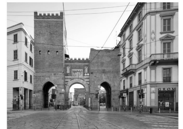
Figur 2.5. Porta Ticinese, Milan, Italia. Gjennomgikk en restaurering av Camillo Boito. (Fotograf: Marco introini)
