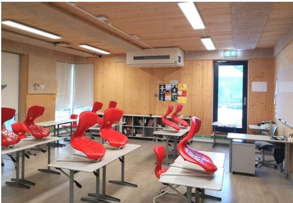
Figur 1-1 Interiør fra klasserom med eksponert massivtre på vegger og i tak (Foto: HS Stokkenes)
