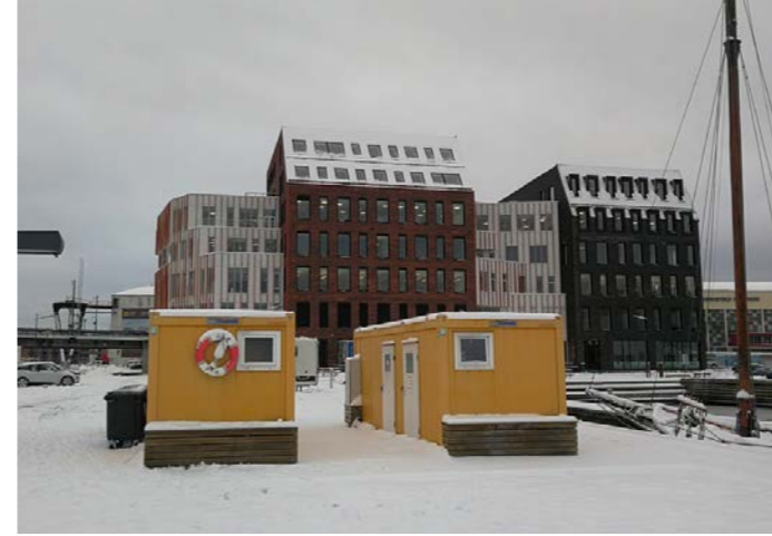
Figur 19. Kerebel & Skråning. (2022). Fredrikstad gjestehavn mot Dokka 6. Ved Fredrikstad gjestehavn og bobilparkering har det nye kontorbygget kalt Dokka 6 blitt bygget. Dette markerer starten på den framtidige utviklingen som skal skje på FMV.
