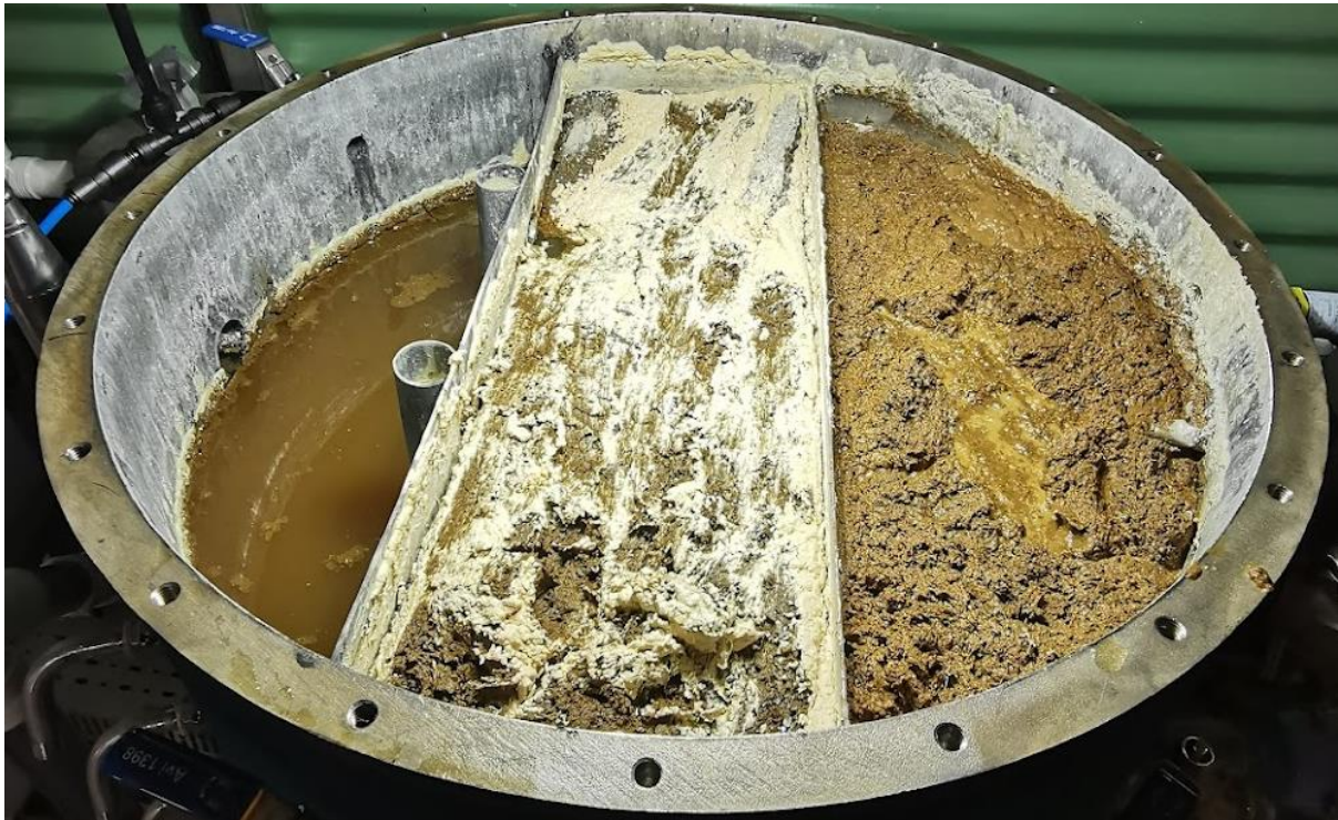
Figur 29: Bilde av det flytende slamteppet, tatt av Andreas Stenseth 3 februar.
