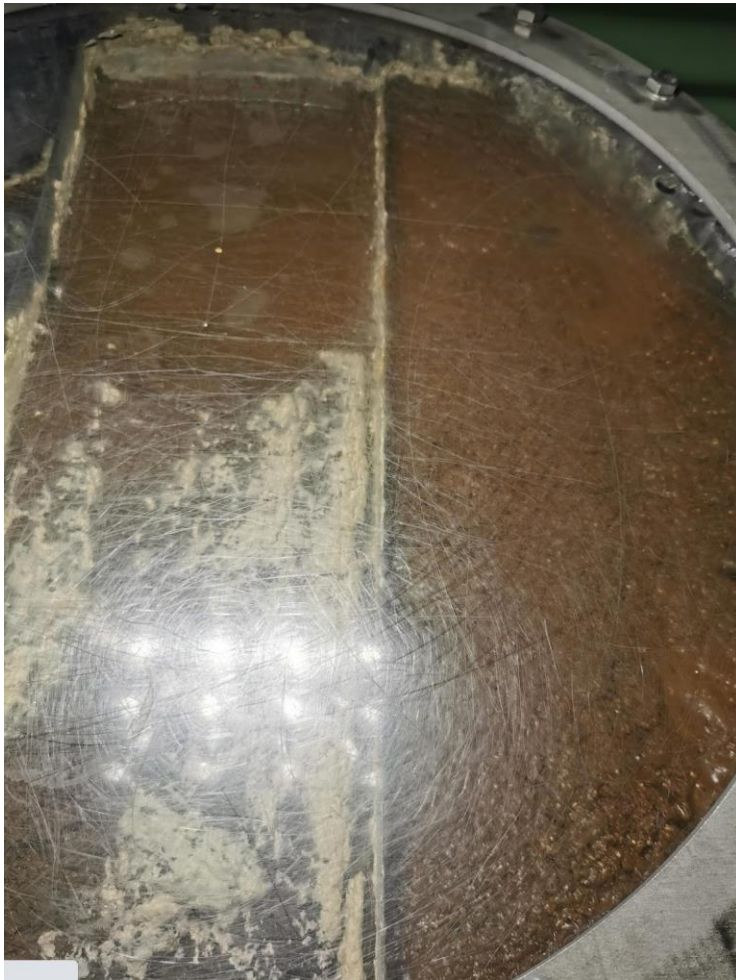
Figur 43: Bilde som illustrerer at det flytende slamteppet på begge sider av den vertikale skilleveggen i kammer 1 begynner å gå i oppløsning, tatt av Andreas Stenseth 12 april.
