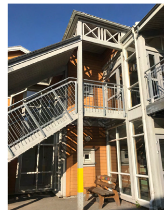
Figur 31: Ståsted 3 med lite rom under trapp
