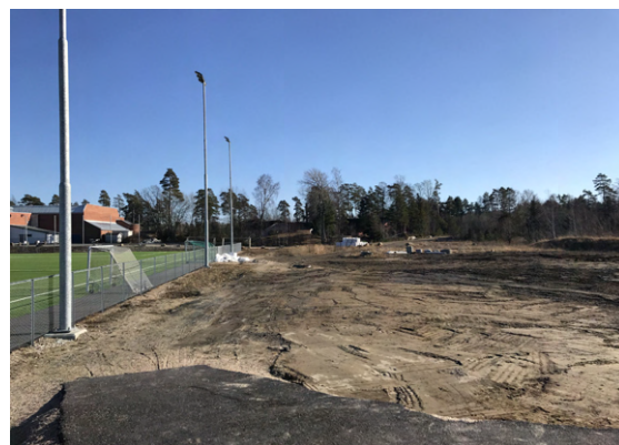
Bilde 155: Uferdig areal ved "Pumptrack"
