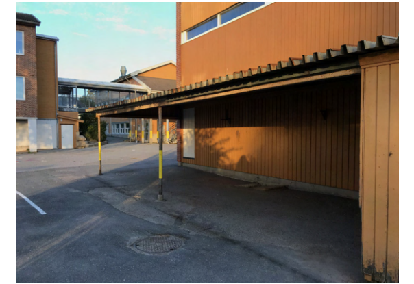
Bilde 32: Ståsted 4 med takutstikk over nødutgang ved gymsalen
