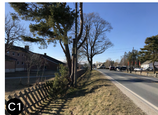
Bilde 147: Skrånende restareal langs Lervikveien mangler fortau
