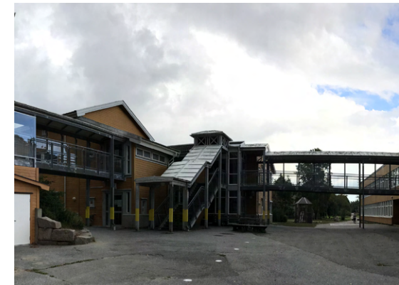
Bilde 141: Tomt asfaltert rom mangler bygde elementer eller vegetasjon for lek
