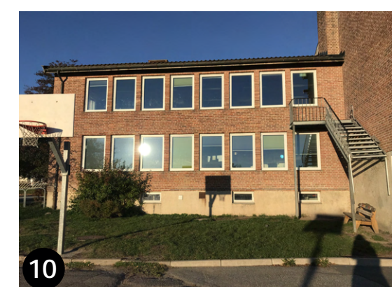
Bilde 72: Trapp ved nødutgang for 1954-bygg
