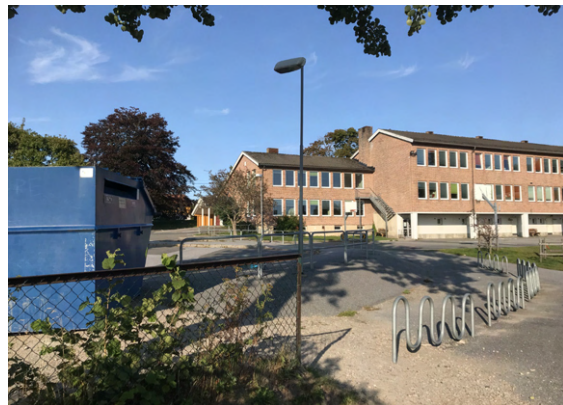
Bilde 83: Skråning på 0.8 meter ved sykkelparkering
