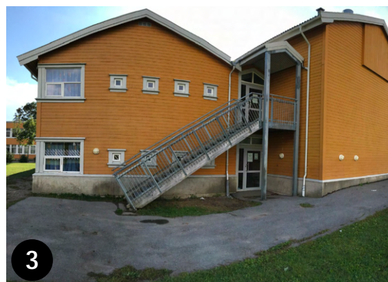
Bilde 65: Trinnfri inngang og trapp for 1997-bygg
