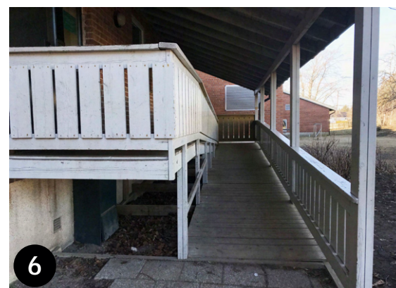
Bilde 68: Rampe til administrasjon for 1954-bygg
