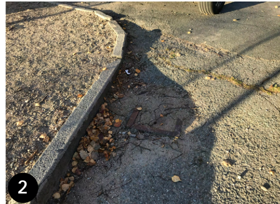
Bilde 74: Sluk tettet av grus
