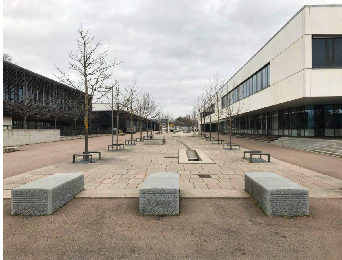
Bilde 163: Sentral hovedgate i anlegget, med allé
