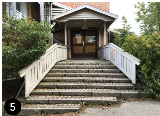
Bilde 67: Trapp til administrasjon for 1954-bygg
