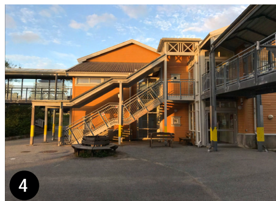
Bilde 66: Trinnfri inngang og trapp for 1997-bygg
