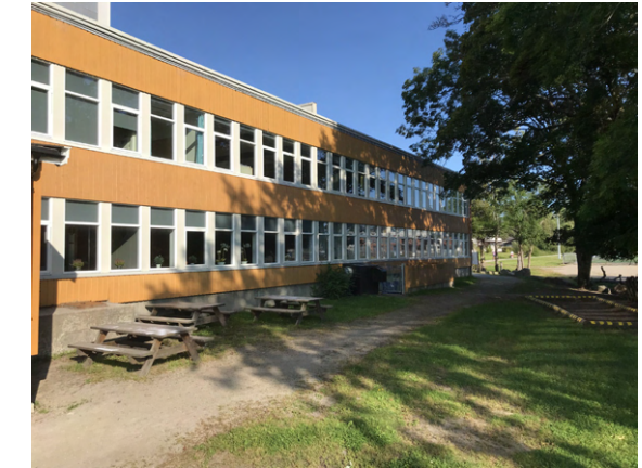
Bilde 128: Lite tilbud i lekefunksjoner og malplasserte benker. Ventilasjonsboks i bakgrunnen fremstår visuelt skjemmende
