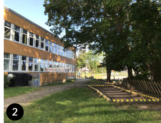
Bilde 47: Ventilasjonsboks, trapp ved nødutgang til kjeller og sandkasse
