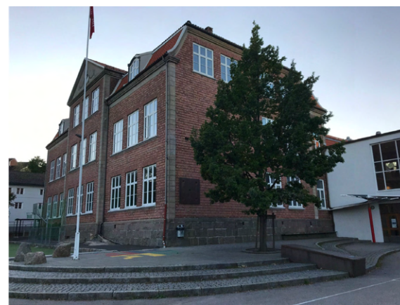
Bilde 160: Terrassert gulv. I bakgrunnen er veggen hvor tretribunen lå langs med
