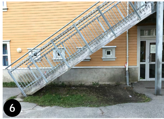
Bilde 78: Oppsprukket asfalt
