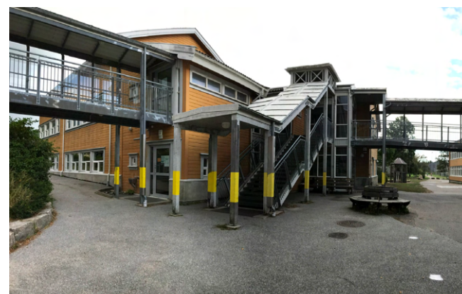
Bilde 30: Ståsted 2 med takutstikk over ståltrapp
