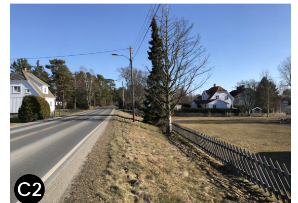
Bilde 148: Skrånende restareal langs Lervikveien mangler fortau
