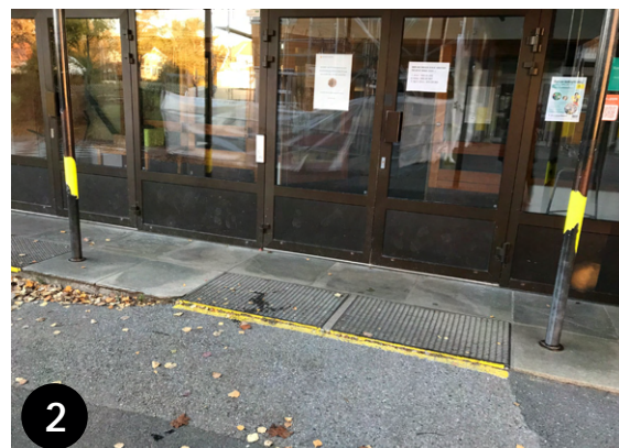
Bilde 64: Trinnfri inngang for 1970-bygg
