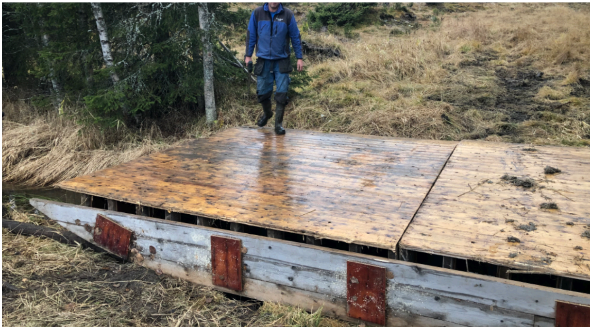
Figur 10- Skribru laget av gjenbrukte forskalingsklemmer fra tunell på strekningen (Statens vegvesen, 2020)
