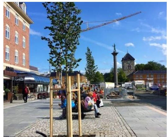
Figur 31 Kongens gate rett etter ferdigstilling i 2018. Foto: Trondheim kommune. Skiferplater danner to gangsoner, i møbleringssonen i midten er rettvisklet rekkesteinsatt smågatebrostein Fra Trondheim 2030 - magasinet om byutvikling ( https://trondheim2030.no/20 ).
