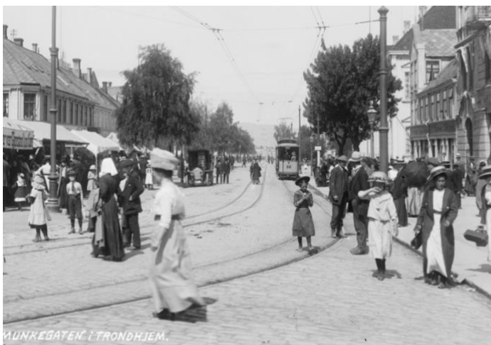
Figur 40 Trikkeskinner gjennom Torvet og ut i Munkegata. Årstall ukjent. Storgatestein lagt med rettvinklet rekkesteinsetting. Foto: K. Knudsen. Fra MARCUS. ubb-kk-pk-0632.
