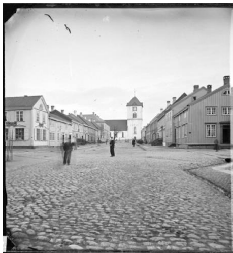
Figur 21 Et parti fra Nordre gate viser at ikke alle områder hadde rett-hogget brostein i midten, og hvor ujevnt dette kunne bli. Ca. 1870-1880. Foto: Hans Krum. Fra Digitalt museum. FTF.SCH.DOK.063.18.01-02.
