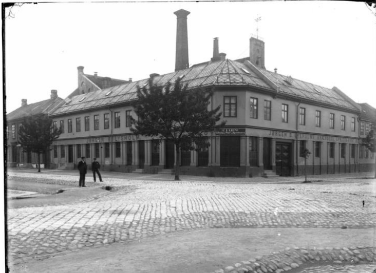
Figur 20 Krysset mellom Nordre og Olav Tryggvasons gate, ca. 1880. Bildet viser en tydelig fargeforskjell mellom midterste, og ytterste del av kjørefeltet. Stein lagt i skråvinklet rekkesteinsetting. Foto: Hans Krum. Fra Digitalt museum. FTF.SCH.000048.
