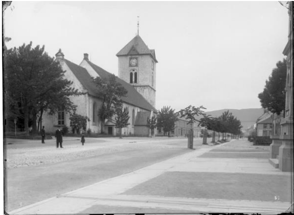
Figur 18 Kongens gate, 1882. Eksempel på bruk av skiferplater på innerste fortau. Foto: Hans Krum. Fra Digitalt museum. FTF.SCH.000019.
