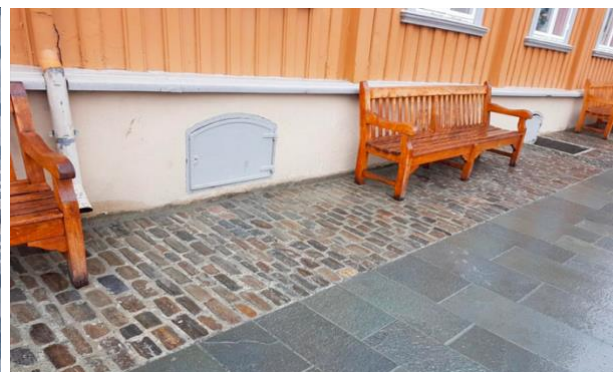
Figur 47 Møblert sone inntil husvegg lagt med rettvisklet rekkesteinsetning med gjenbrukt storgatestein fra 1800-tallet. Foto: Ukjent. Fra Agraff AS
