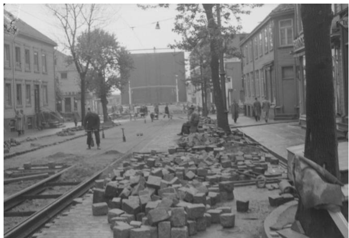
Figur 57 Veiarbeid i Søndre gate, 1950. En brolegger benytter seg av en "jomfru". Foto: Schrøder. Fra Digitalt museum. FFTF.SCH.V.018250.
