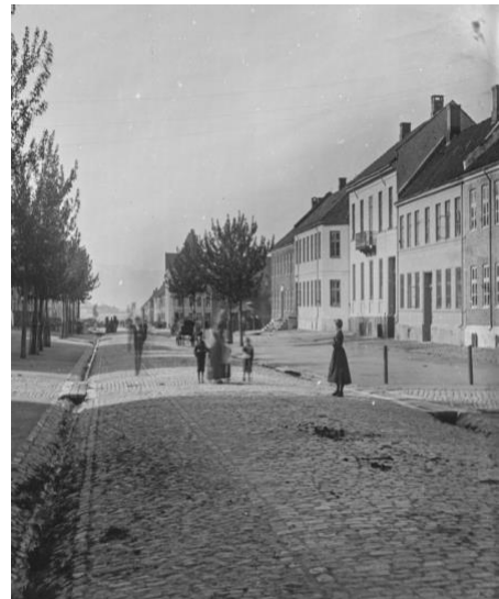
Figur 23 Munkegata, 1875. Forskjell i type brostein brukt i kjørefelt. Stein lagt i rettvinklet rekkesteinsetting. Foto: Knud Knutsen. Fra MARCUS. ubb-kk-ns-1344.
