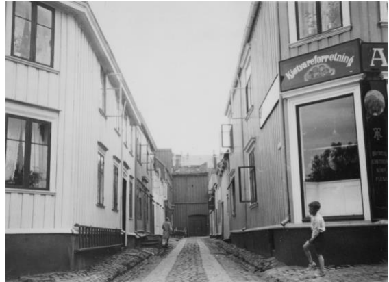
Figur 12 Brandhaugveita, 1930. Brostein med jevn overflate lagt i hjulspor for lettere fremkommelighet med vogn eller bil. Foto: Arne Jacobsen. Fra Trondheim byarkiv. A1.S4.P1.BP0020
