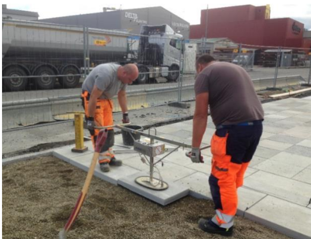
Figur 59 Anleggsgartnere legger skiferplater for testfelt i forbindelse med det nye Torvet. Foto: SINTEF. Fra «Torvet i Trondheim – Testfelt Natursteinsdekke Nyhavna», Alnæs, et al.
