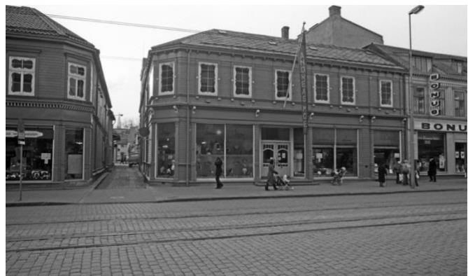
Figur 26 Olav Tryggvasons gate 31 i 1972. Storgatestein lagt med rettvinklet rekkesetting. Foto: Ukjent. Fra Trondheim byarkiv. Tor.H43.P3.F10842.
