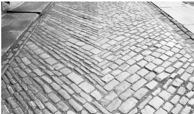
Figur 13 St. Jørgensveita, ca. 1970. Brolagt med diagonal rekkesetting/fiskebeinsmønster. Fra Trondheim byarkiv. Tor.H43.P03.F14181
