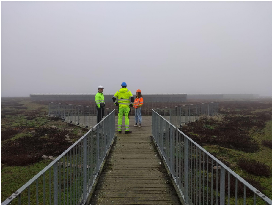
Figur 4: Bildet er fra sedumtaket til Norsk Gjenvinning på Haraldrud i Oslo på senhøsten. Foto av Fredrik Skistad
