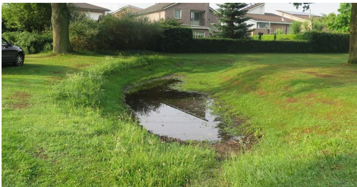
FIGUR 3 GRØNT FORDRØYNINGSBASSENG (TRINN 2) (NGU, 2018)
