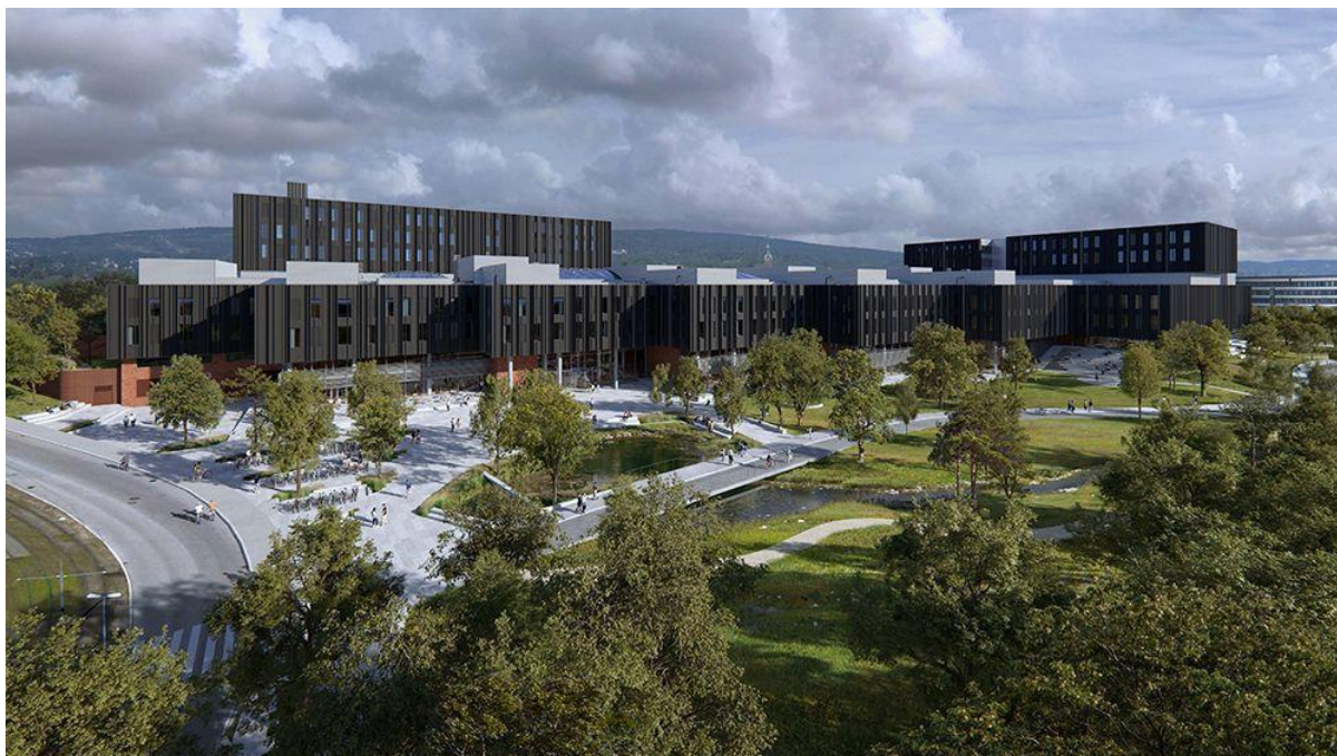
Figur 10: Oversiktsbilde av prosjekt LVB (UiO, 2021).
