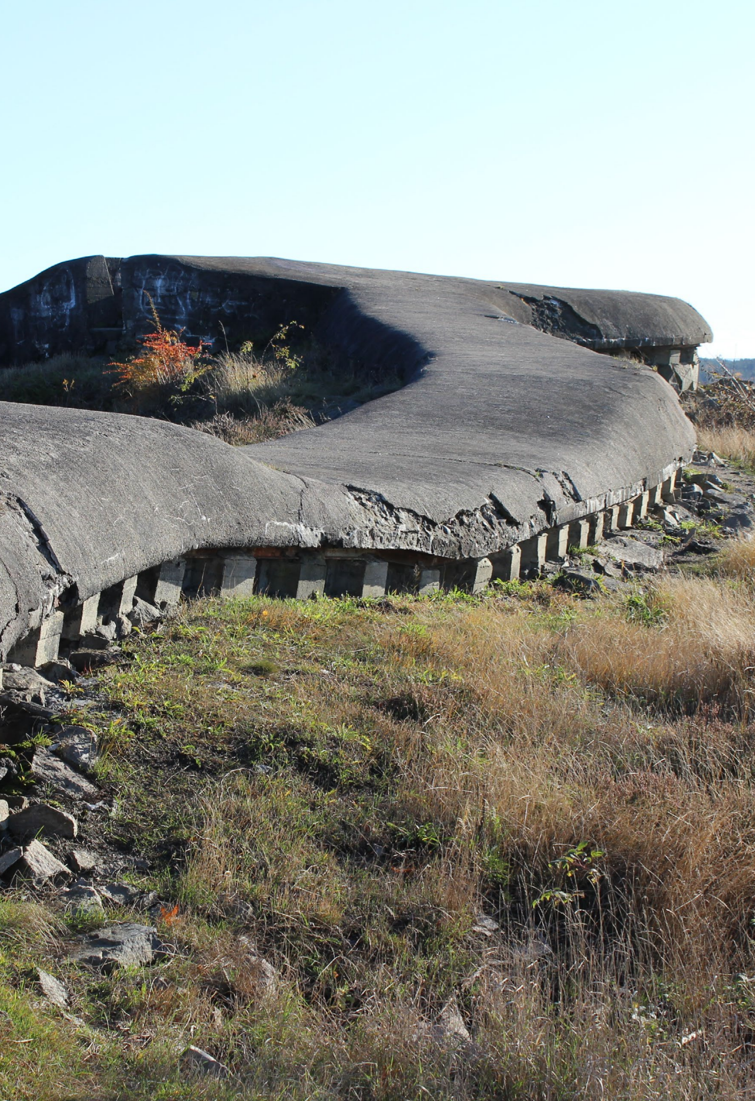
Fig 3.1: Geværgalleri ved Greåker fort som slynger seg etter terrenget
