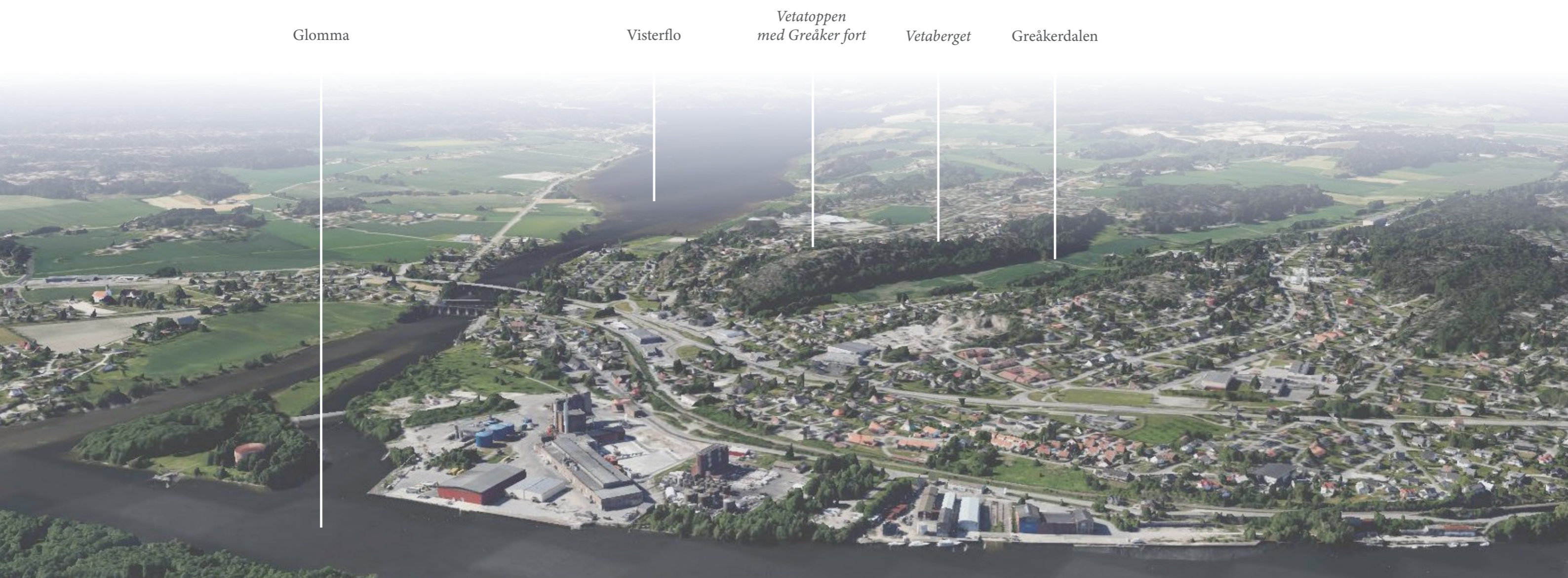
Fig 3.19: Greåker tettsted med Vetaberget (Google Earth, 2019b)
