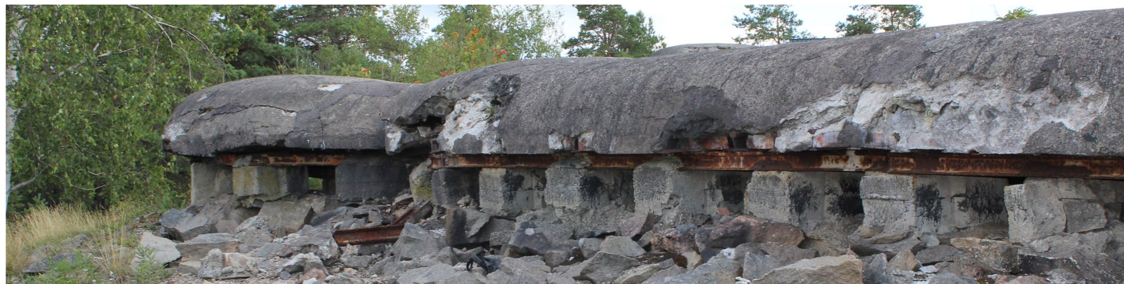
Fig 3.45: Fortets byggverk er i mange tilfeller blitt offer for manglende vedlikehold, og tråkk gjør skader verre. Her vises Sydfrontgalleriet
