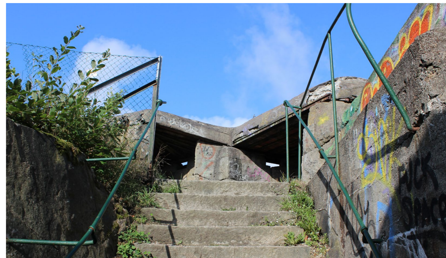
Fig 4.60: Eksisterende armatur ved fortet
