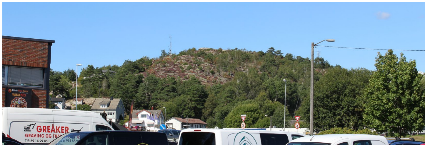
Fig 3.23: Fortet sett fra Greåker sentrum syd for Vetaberget. Vegetasjon rundt fortet skjuler det delvis i fra flere retninger
