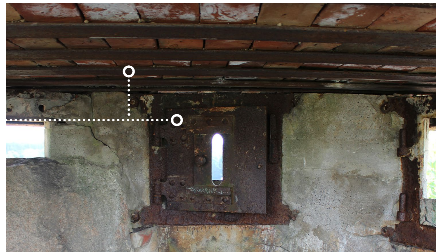
Fig 4.28: Armatur fra et mitraljøserede ved fortet
