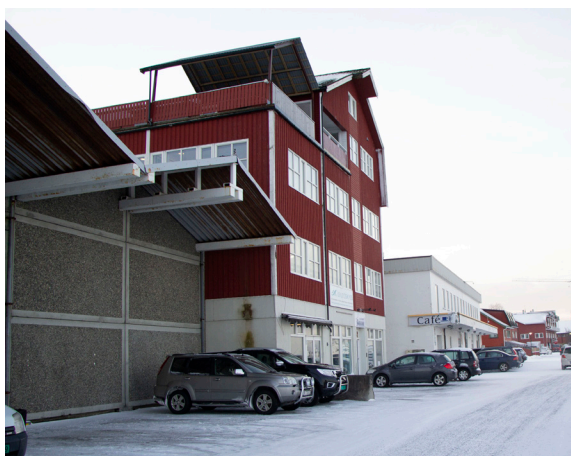
Figur 4.63 Grått lagerbygg i Torolv Kveldulvsons gate 37
