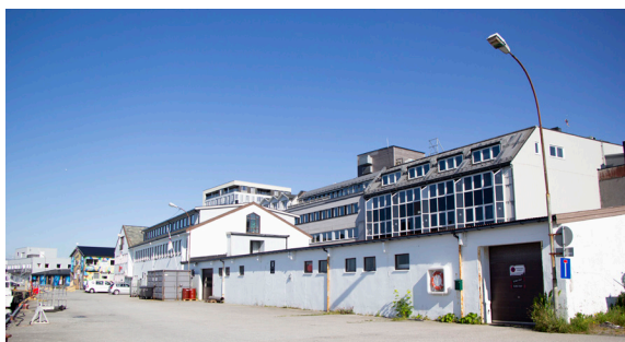
Figur 4.62 Hvitt lagerbygg på Havna i Helgelands gate 1
