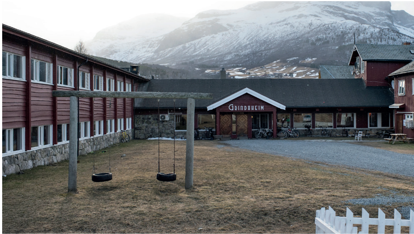
Figur 24: Vang mottakssenter inneholdt gresskleddede utearealer med lekestativ og benker med bord (HERO, u.å.),
