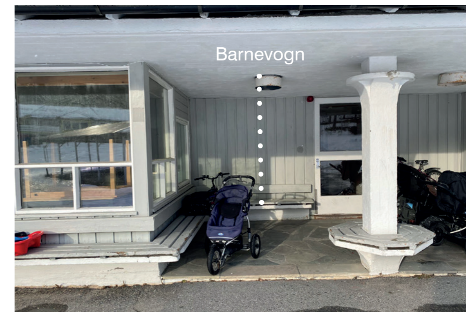
Barnevogner opptar oppholdssoner med innebygd tak.
