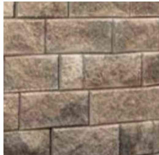
Figur 46: Støttemur av betongblokker (Asak miljøstein, 2021).
