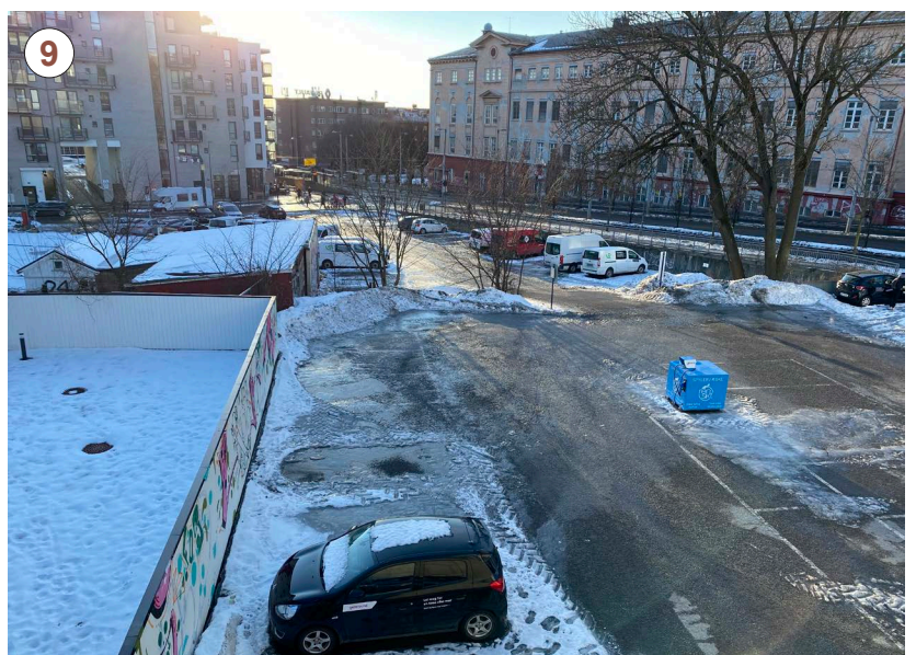
Parkeringsplassen sett fra enden av takarealet, der en ståltrapp går ned bak et tett tregjerde. Takarealet har en svak tilknytning til plassen.
