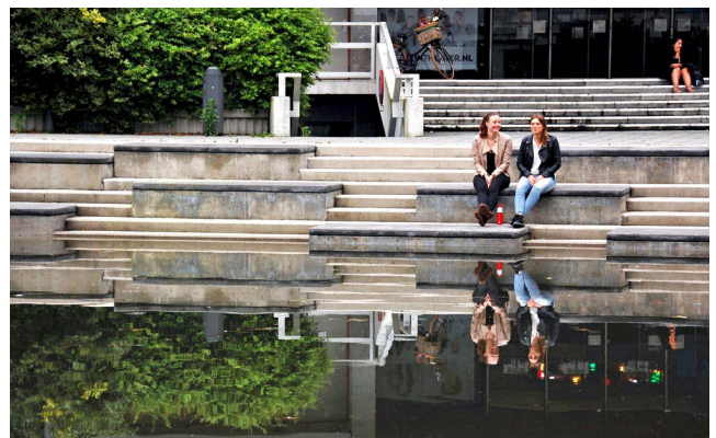
Figur 2.15. Tredje basseng etter en større regnbørshendelse. Vanligvis fungerer magasinet som ballbane.
