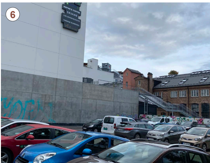
En seks meter høy betongmur langs Carl Berner Passasjens hvite gavlvegg forsterker byrommets tunge og grå uttrykk.
