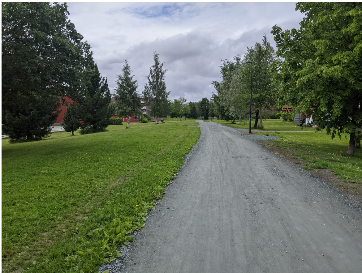
Gangvei ved punkt 25.
