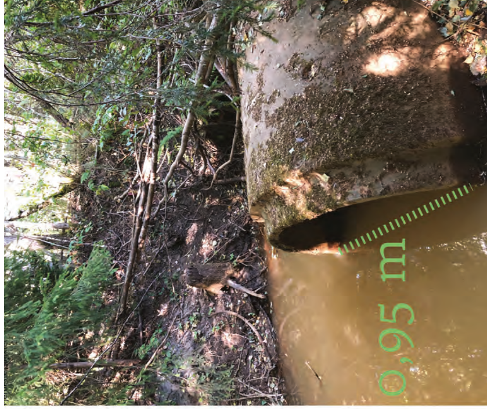
Etter oppmåling på stedet har røret indre diameter på 0,95 m.
