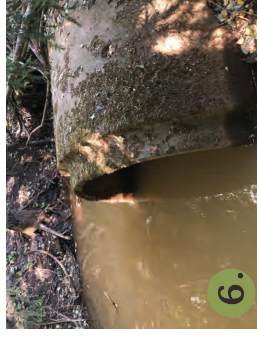
Utløp fra betongrør i skogsholtet øst for jernbanelinjen
