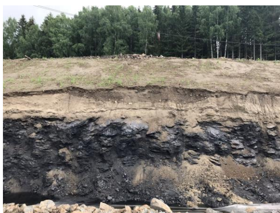
Figur 8: Det øverste bildet viser tverrsnitt av elvekanal med grove avsetninger i mai 2020 før avdekking helt ned til alunskifer. Skrå lag med godt sortert medium sand til venstre for elvekanalen er karakterisert som point bar avsetning. Bildet nedenfor viser samme område i juni 2020 etter avdekking, stabilisering av løsmasseskråning og pigging ned til traubunn. Overgangen fra breelavsetninger til den underliggende alunskiferen (2-3a). Alunskiferen er skifrig og skrår svakt mot NV.
