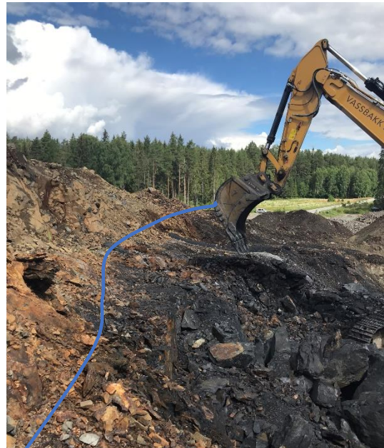
Figur 17: Maskinelt uttak av siste 1-1,5 m med svartskifer inn til mænaittgangen (rustrød). Omtrentlig grense mellom mænaitt og svartskifer markert med blå strek.
