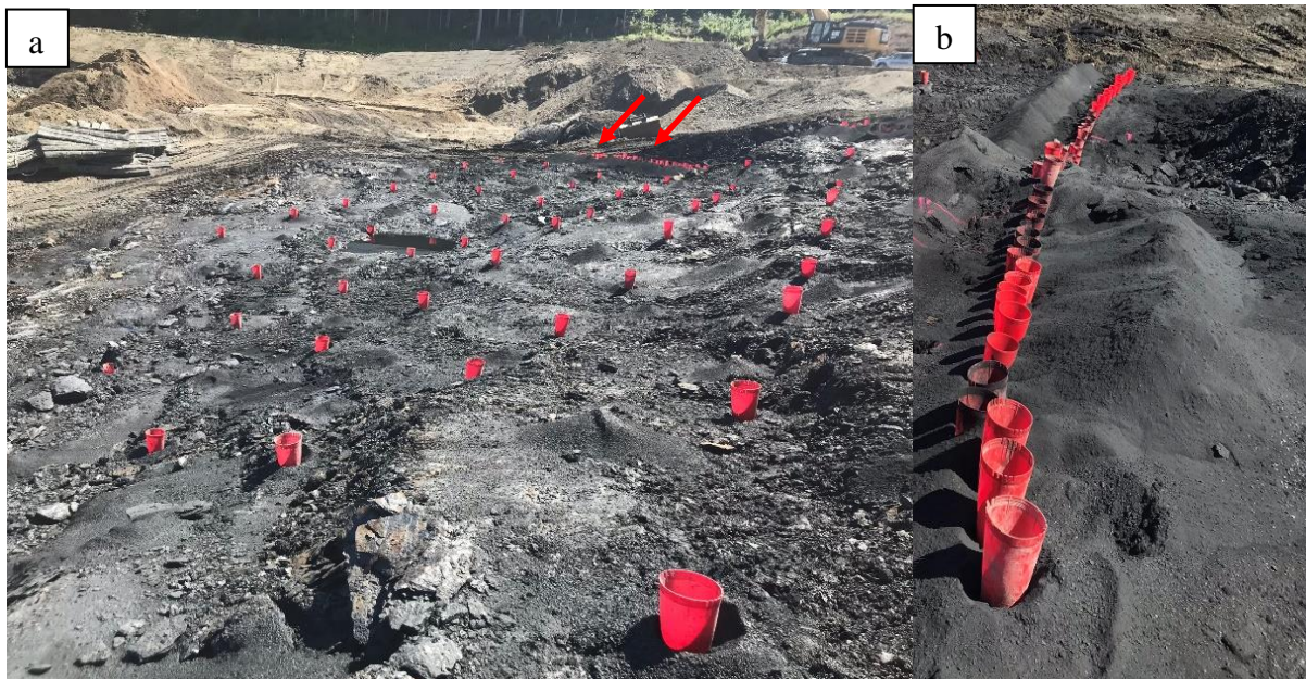
Figur 16: Fordeling av sprengstoffhull ved pallsprenging inn til mænaittgang (a). Kontursømmen langs sørlige veiskjæringsflate er indikert med røde piler. Nærbilde av tett kontursøm (b).
