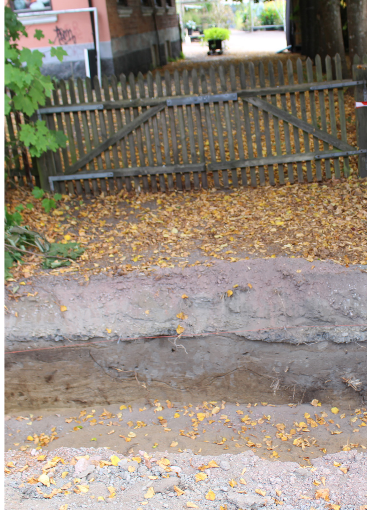
Figur 5.1 Sjakt 1. I sjakten sees rester etter det ene kvarteret i Herregårdshagen som et gråere felt over den gulbrune sandige morenejorda. Gråfargen kommer av at det ble gravd inn leirholdig silt for å gjøre jorden mer næringsrik og for å holde bedre på vannet i jorda (Dietze-Schirdewahn et al., 2022).
