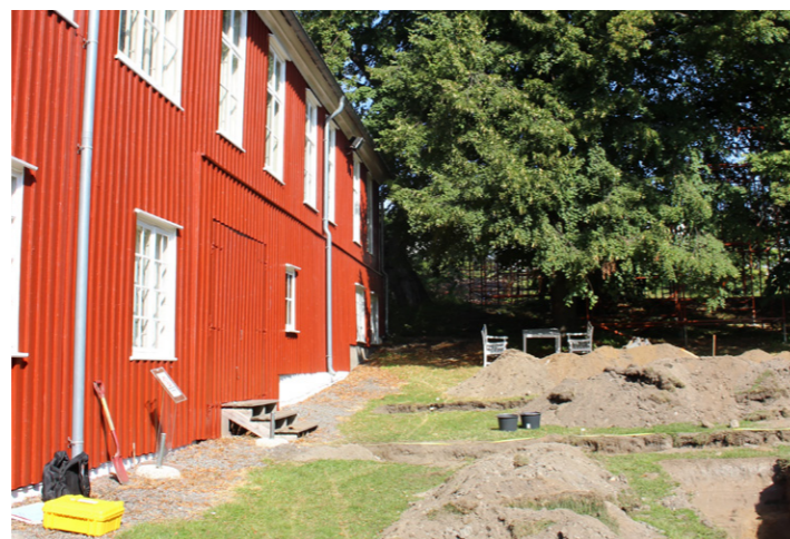
Figur 5.11 Terrenget skråner mot sør langs Herregårdsbyggets østfløy. I dag er fallet her på ca. 1:15 (6,6 %).
