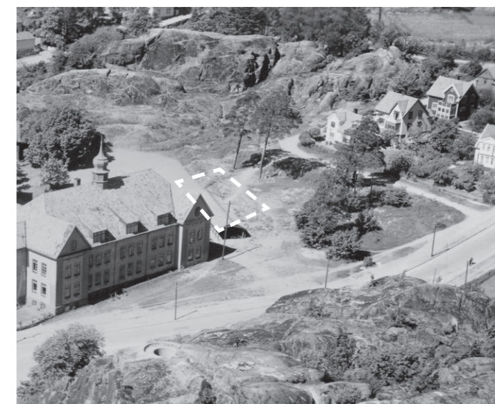
Figur 5.29 Utsnitt av flyfoto over Mesterfjellet skole fra 1951. En kan se hvordan det har blitt fylt på masser i forbindelse med Residensveien. Steinhusets omtrentlige plassering er markert med stiplede strek.
