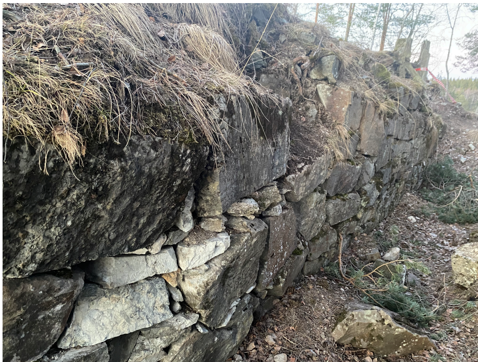
Figur 41: Tørr gjenoppmuring, naturlig toppdekke fremstår bevart. Steinsholmen 18.04.2022. Foto Ole-Berge Olden
