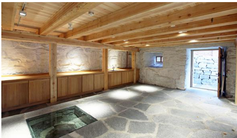
Figur 33: Kjeller med moderne kjøkken og el-installasjoner. Restaurert brønn under glassplate. Foto Arkitektkontoret Schjelderup og Gram. Hentet fra: https://www.sgram.no/prosjekt/abbedens-hus-utstein-kloster 11.05.2022
