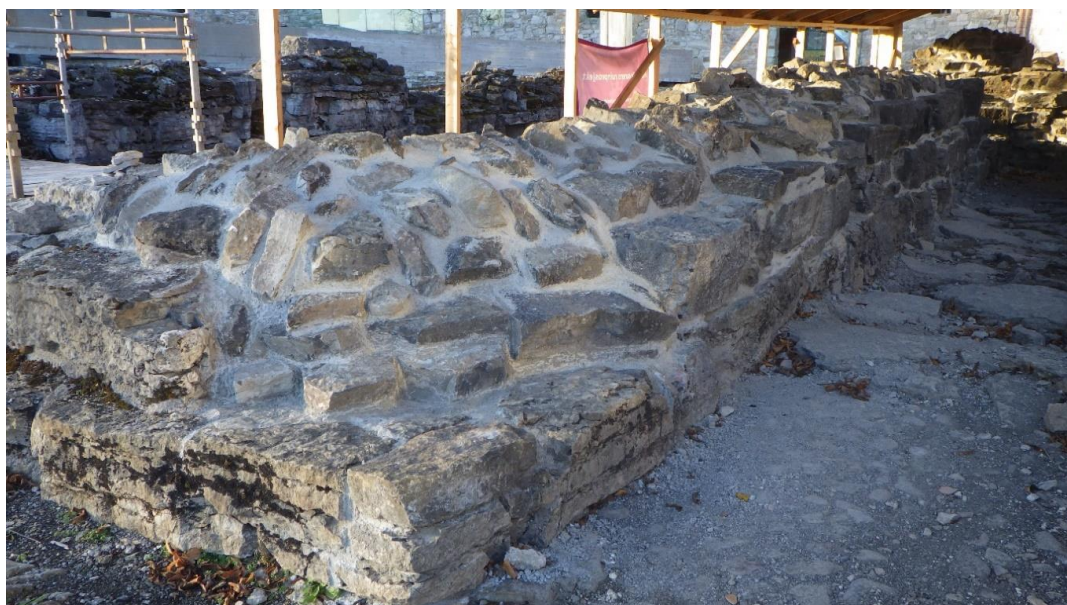
Figur 27: Toppdekket formet som en åpen, brutt kistemur. Fra Rapport Ruinprosjektet (Reinfjord & Bakstad, 2019, s. 9)
