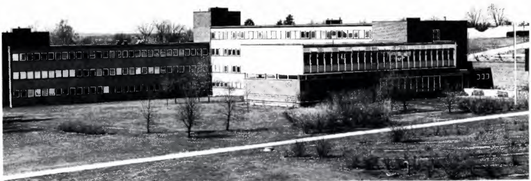
«Fellesbygget» på Ås stod ferdig til innflytting høsten 1958
