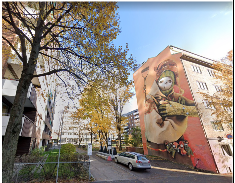
Sidefill. Kilde: Google. (2020). Jens Bjelkes gate 61. Tilgjengelig fra: https://goo.gl/maps/VvEji3SS8SB855oH6 . (lest 13.12.21).
