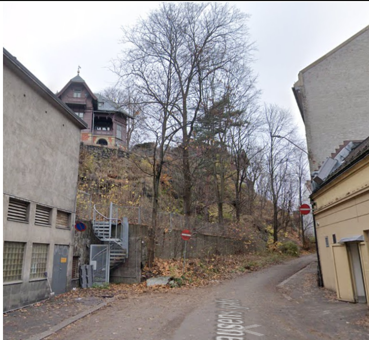
Terreng. Kilde: Google. (2020). Haxthausens gate 10. Tilgjengelig fra: https://goo.gl/maps/c2kUTEouzAuvpatAA . (lest 13.12.21).
