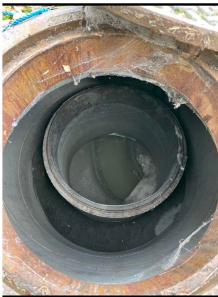
[19] Innløpet er 400mm og utløpet er 250 mm
