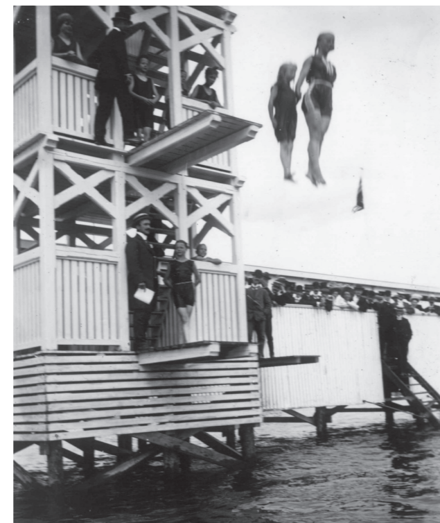
Figur 2.8: Svømmestadion på Filipstad (1933)
