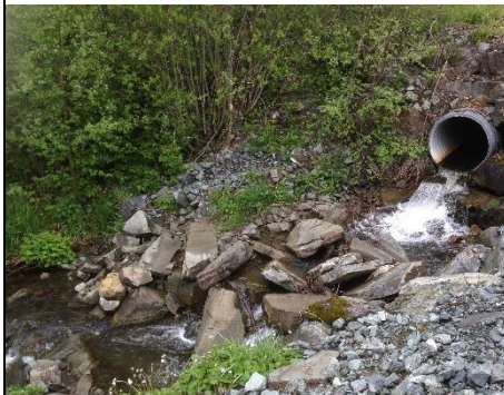
Kulvert med kulpetrapp ved slutten av stasjon 2. Foto: Stian Stensland.
