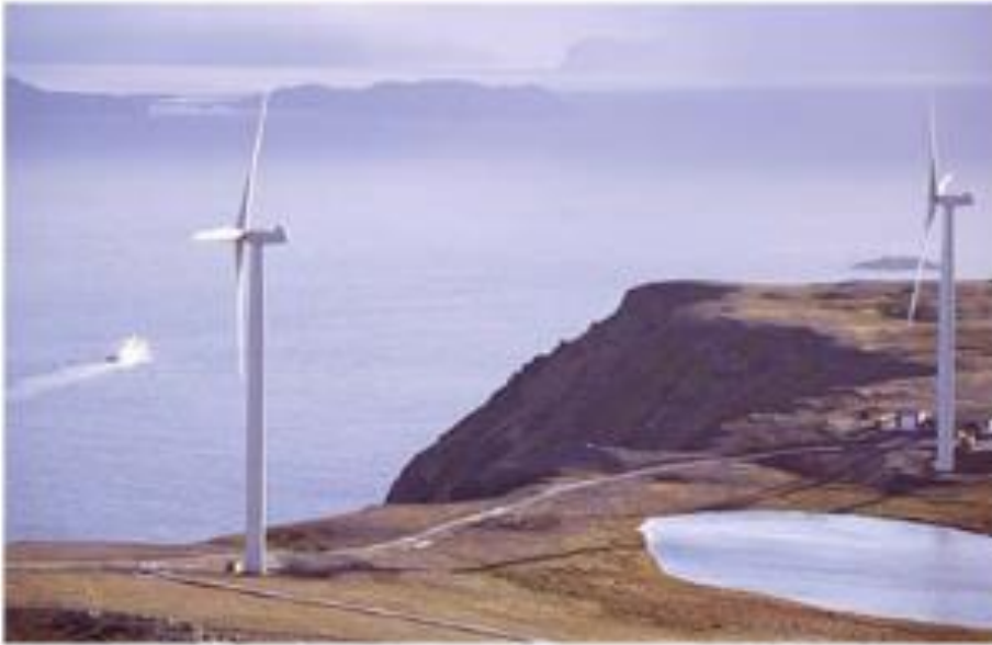
Figur 3.2 Storskala vindturbin. Kjelde: (Eidsiva 2008).
