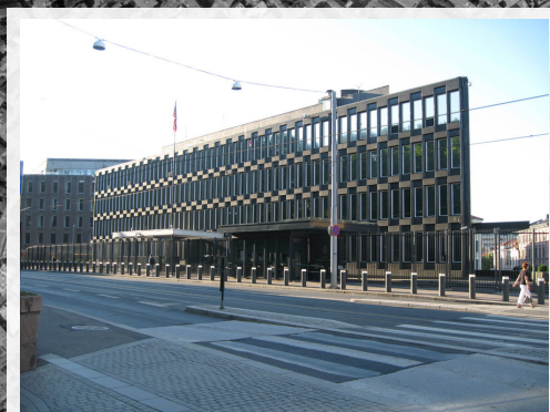
Byrom gruppe B1. Sikrings tiltak rundt den amerikanske ambassade i Henrik Ibsens gate har til hensikt å forhindre både kjøretøy og fotgjengere fra å komme inn på tomten.
