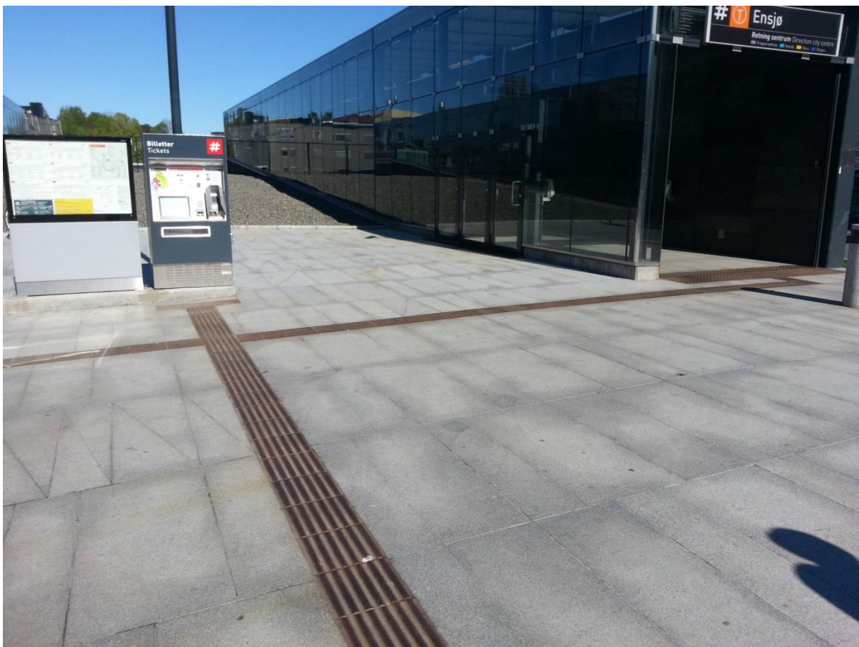
Bilde 1: Ensjø T-banestasjon
