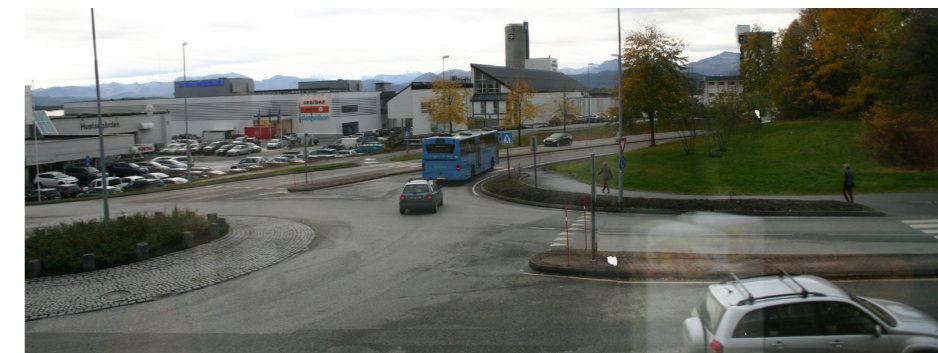
Figur 27: Rundkjøring mellom Molde Storsenter og Roseby. Del av E39.
