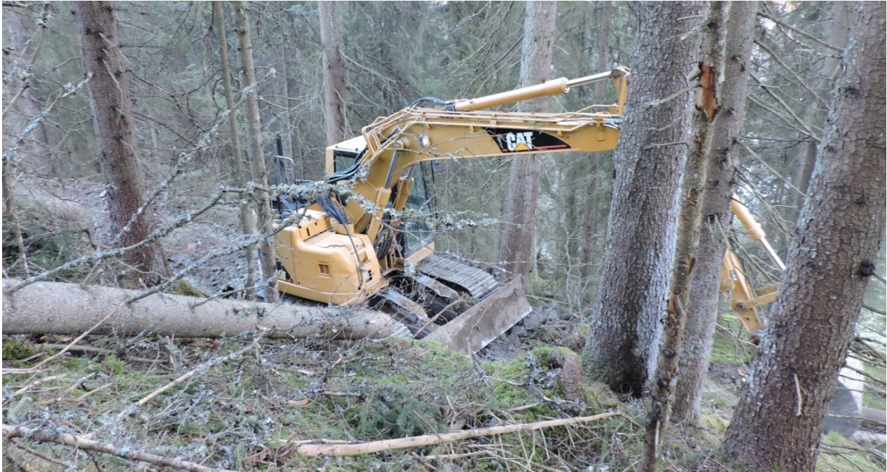
Bilde 7 Caterpillar 314C graver forhåndsfelte driftsveier i bratta i Melhus. Foto: Sverre Husby
