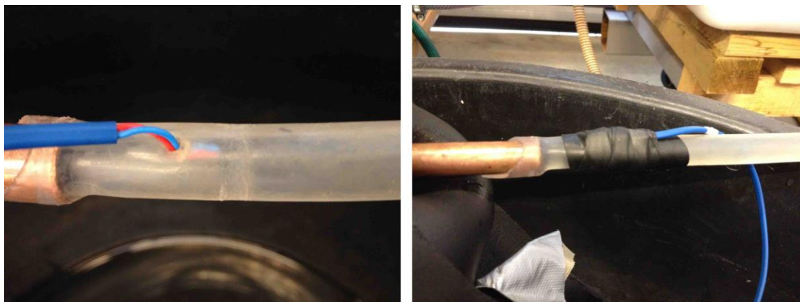
Figur 27 - Ny montering av temperatursensorer. På bildet til venstre er det vist hvordan temperatursensoren er montert i slangen, til høyre er det lagt på isoleringsteip. Denne løsningen ble brukt ved inn- og utgangen til kobberøret.
