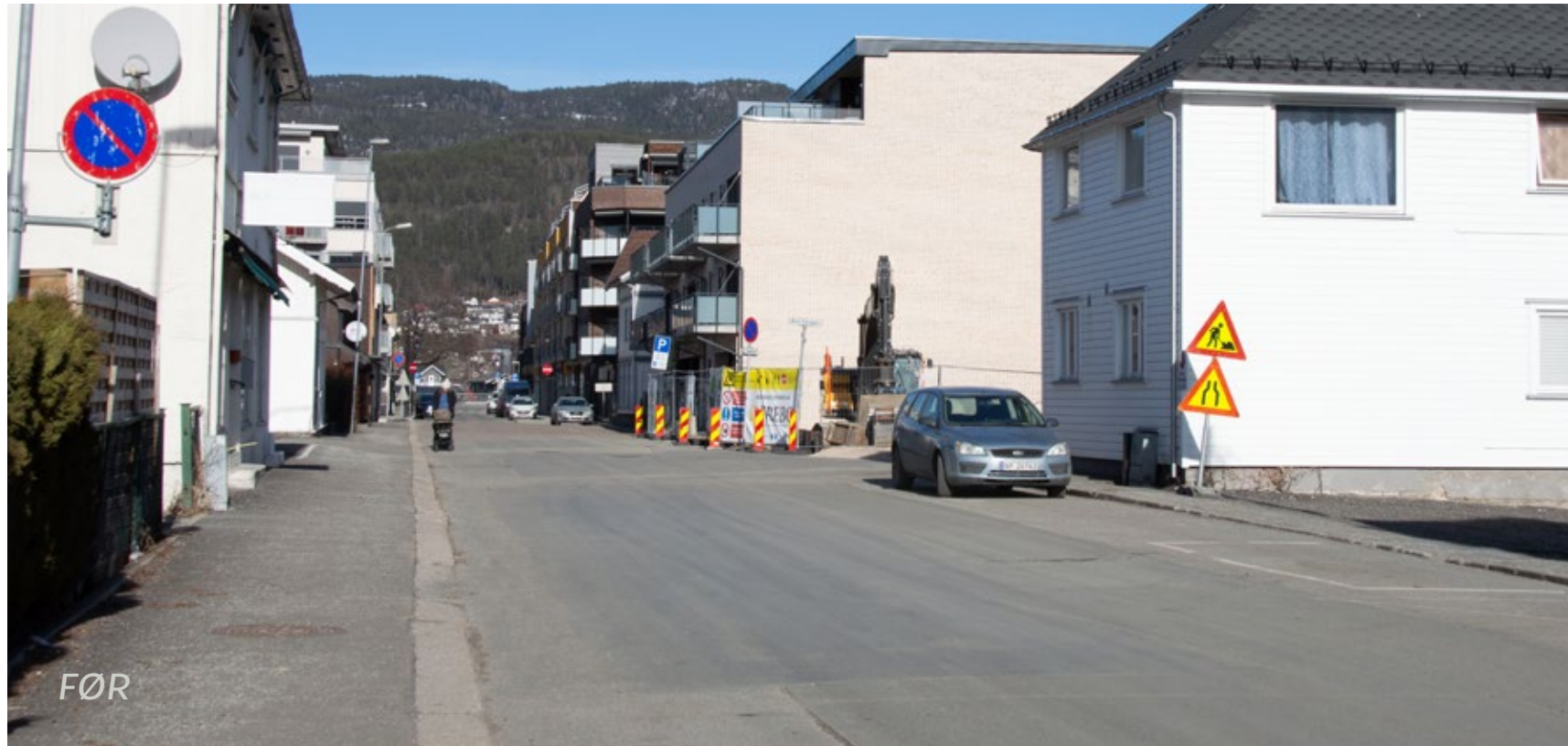
Figur 3.15 Foto av Møllergata fra befaringen i mars 2021.
