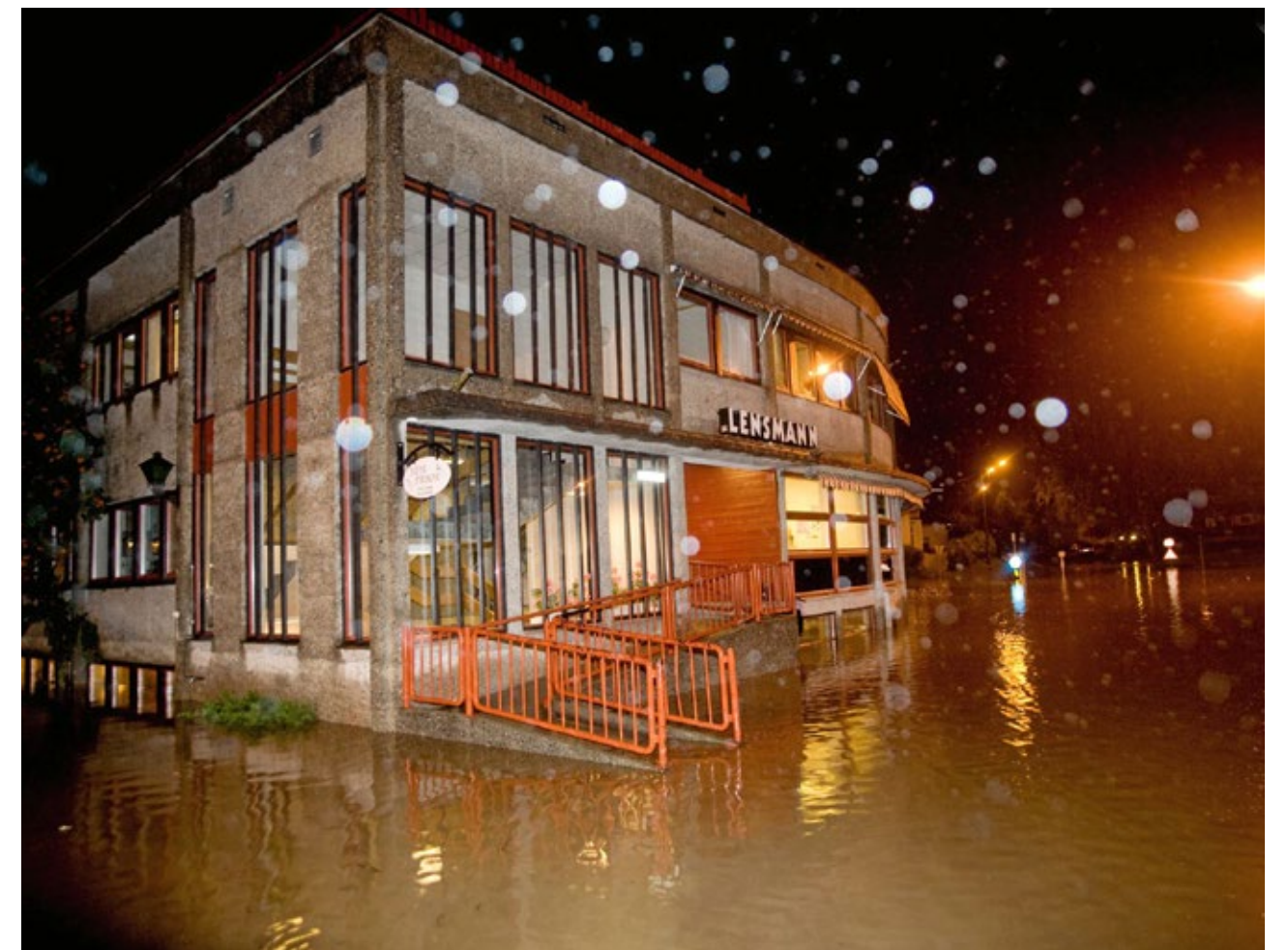
Figur 2.18 Slik så lensmannskontoret ut da Frida rammet Mjøndalen i 2012. På veggen er det merker som tilsier at vannstanden kan ha vært enda høyere enn på bildet. Bygget ligger innenfor prosjektorrådet "Møllerkvarålet". Foto: Ekroll, H. C. (2012) Aftenposten.
