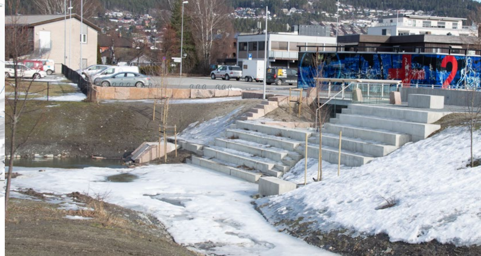
Figur 2.21 Flomsikringsanlegget på Wildenveys plass skal sikre at flom fra Evja ikke renner inn i sentrum.
