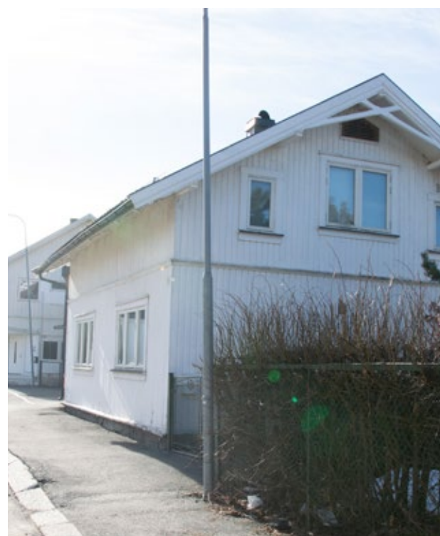
Figur 2.45 Sveitserboligen (kulturminne 8) har middels verneverdi, og ligger helt inntil Møllergata. Bygget er klassifisert som privatbolig.
