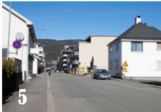
Figur 2.65 Møllergata sett fra sør
