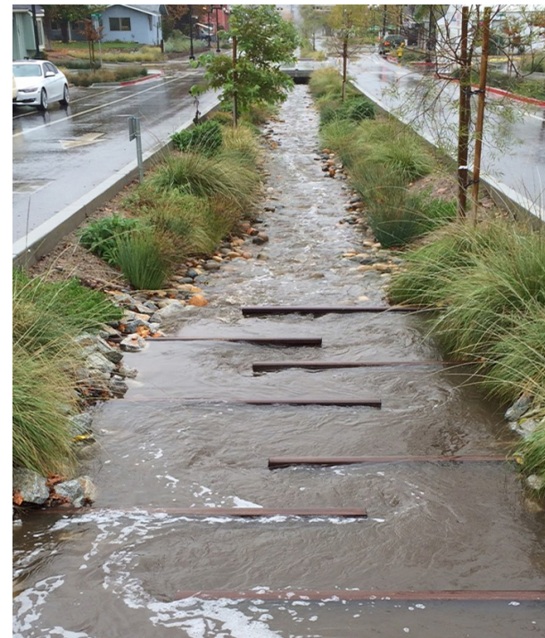
Figur 2.6: Åpen overvannshåndtering ved 21st street Paso Robles. (Foto:svrdesign, u. å.)
