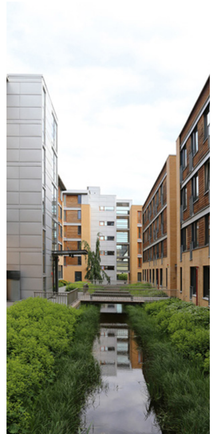
Figur 2.7: Eksempel på fordrøyning med åpent magasin og permanent vannspeil i Bjølsen studentby. (Foto: LMR, u. å.)
