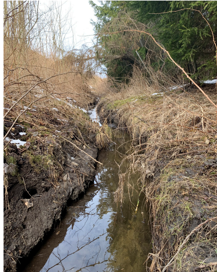
Figur 4.4: Kantsonen til Hogstvetbekken er bred og gjengrodd, men ligger dypt i terrenget. Gjerdet mellom bekken og hagene er så vidt synlig innimellom trærne til høyre.
