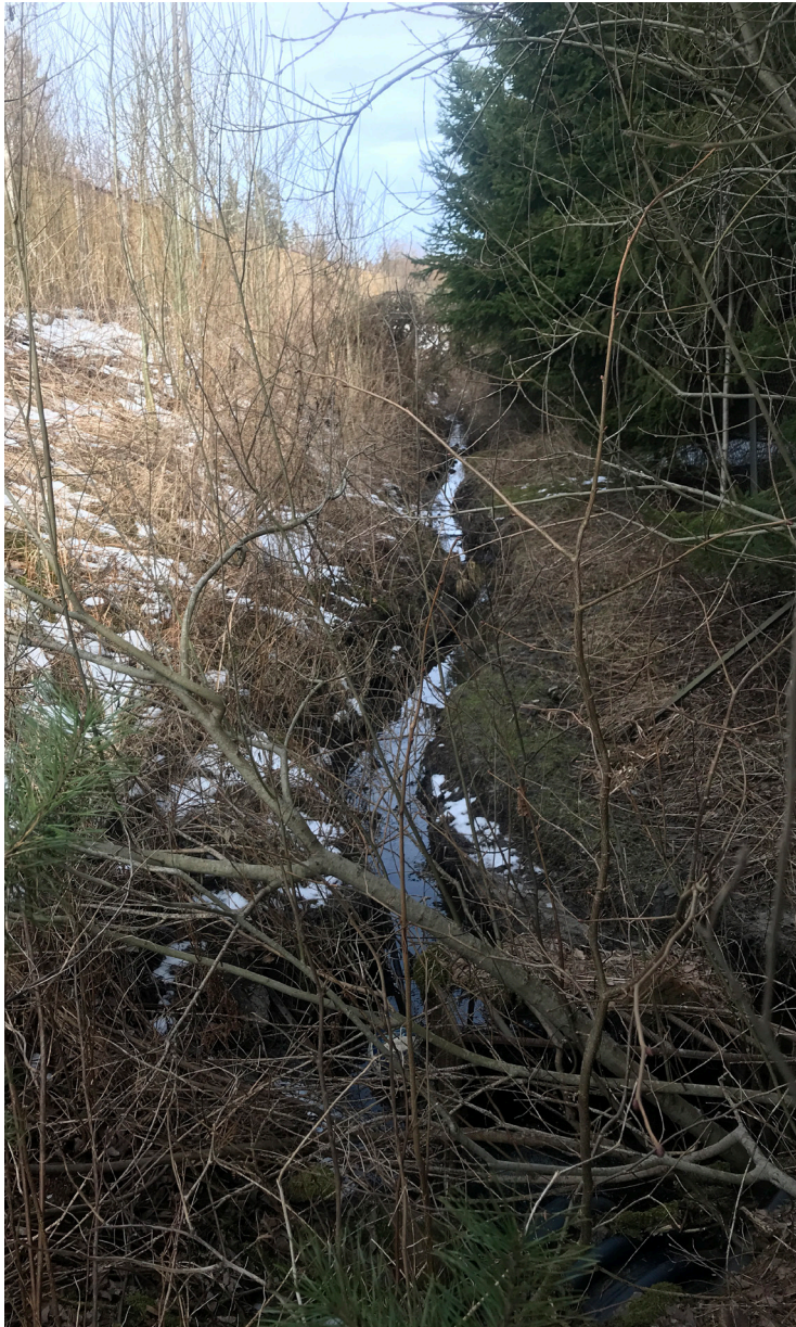
Figur 4.3: Bildet viser stedet hvor Hogstvetbekken går i rør. (s.51). Stedet er utilgjengelig på grunn av gjerder, skog og kratt. Jernbanen går bak og langs gjerdet til venstre i bildet.
