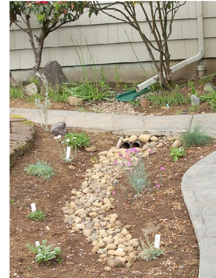
Figur 2.20: Frakoblet taknedløp er et billig og enkelt tiltak som avlaster overvannsnettet. (Foto: karenmarie503, 2008)
