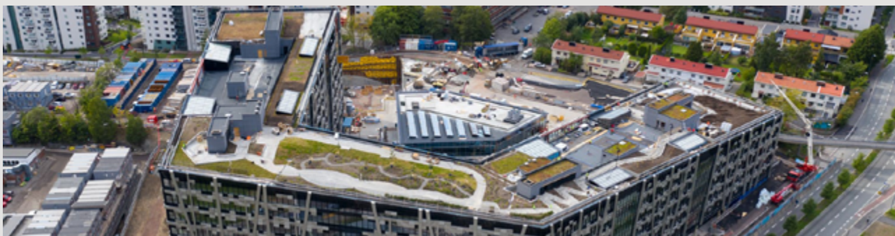
Figur 31 - Taket på Økern Portal. Foto: Christian Grønvold Hansen.
