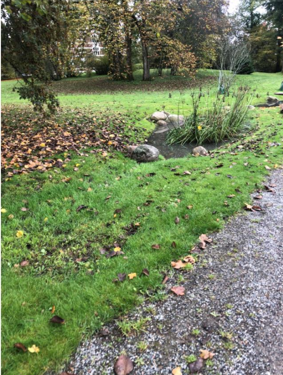
Bilde 2.1. Løsning for overvannshåndtering som en naturlig del av grøntområde på Norges miljø- og biovitenskapelige universitet, NMBU. Foto/kilde: Eget foto.
