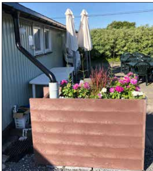
Figur 1: Miniregnbed ved Sogn hagekoloni tilkoblet tak gjennom taknedløp og vannførings splitter. Ytre mål er 138, 62 og 90 cm for henholdsvis lengde, bredde og høyde. Vannføringssplitteren er av typen Regendieb Pro (GRAF, u.d.). Foto: Bent C. Braskerud.
