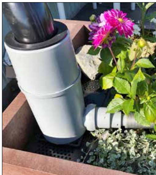
Figur 1: Miniregnbed ved Sogn hagekoloni tilkoblet tak gjennom taknedløp og vannførings splitter. Ytre mål er 138, 62 og 90 cm for henholdsvis lengde, bredde og høyde. Vannføringssplitteren er av typen Regendieb Pro (GRAF, u.d.). Foto: Bent C. Braskerud.
