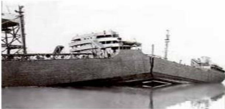
Figur 1.8: Illustrasjon av hvordan et av Liberty-skipene brakk i to mens det lå i havn. Årsaken til utmattingsbruddet var helsveiste konstruksjoner som ved store spenningskonsentrasjoner samt lav temperatur og bruddseighet førte til sprekkvekst og sprøbrudd, deretter utmattingsbrudd [1].
