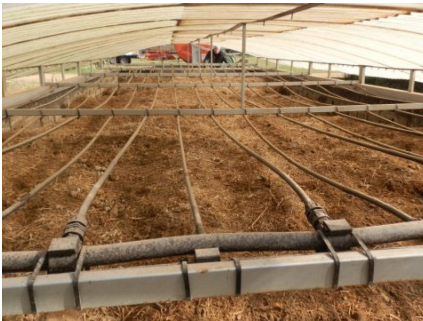
Figur 3. Tilførsel med dryppvanning i et Phytobac anlegg ved College Farm. (Foto: Bill Basford).
