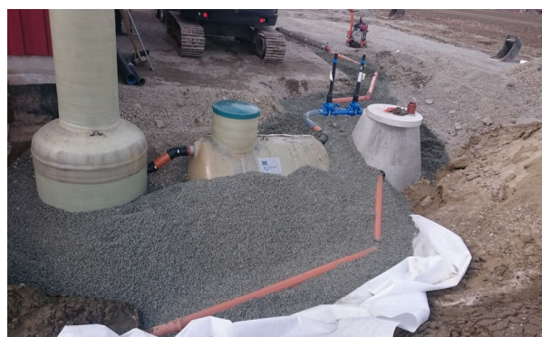
Figur 7. Installering av sandfang og tank for oppsamling av vann. (Foto: B.K. Snapa).
