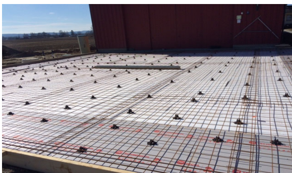
Figur 8. Isolering og armering før støping av betongplattning. (Foto: B.K. Snapa)
