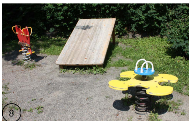
8 Vippedyr ved småbarnsavdelingen. Vippene er slitt og mangler fotstøtter.
