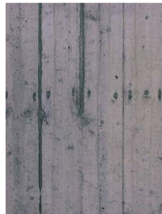
Figur 5.8: Betongkanter med tydelig stryktur fra forskalingen
