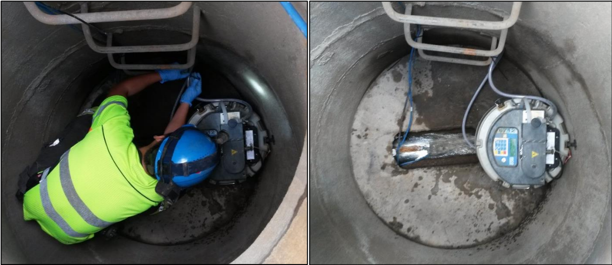
Figur 20: Bilde fra installasjon av prøvetaker og måler i kum 274119.
