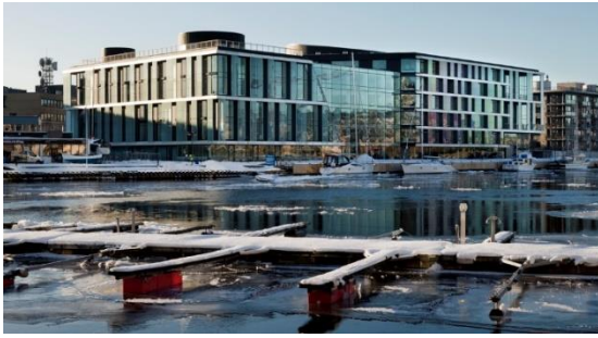
Figur 1 Fasade Tangen vgs. (Bilde hentet fra: http://glamox.com/no/referen/indeks-huset-i-oslo )
