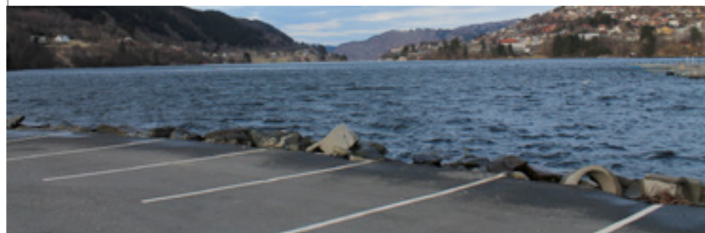
Bilde 35 Parkering langs fjordfronten
