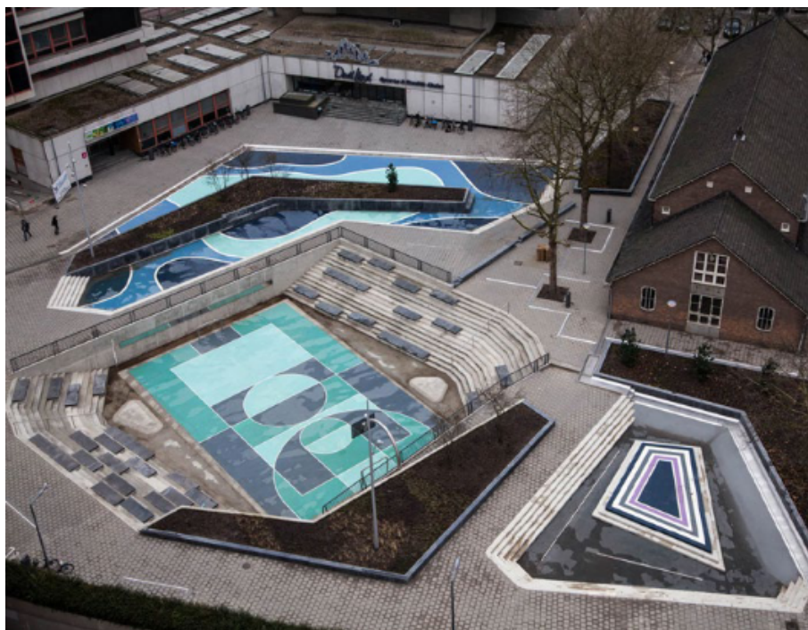
Figur 4.11: Terrengeforsenkning og fordrøyningsmagasiner på torget Bentheimplein i Rotterdam, Nederland Foto: Pallesh og Azarfan, 2014
