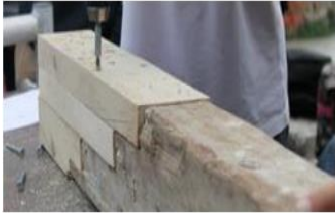
Figur 49 Bilde av montering av protese i et horisontalt element ved hjelp av selv borende skruer. Hentet fra Franke et al. (2015)
