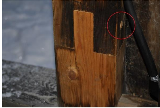
Figur 52 Bildet viser baksiden av protesen som er vist i figur 51 (a). Her vises det at en plugg er satt inn på tvers av flensen som er faset ut, og dermed låser forbindelsen i lengderetning til flensen. Denne er gjemt på innsiden for å bevare mest mulig originalt utseende. Foto: Trym Lunder Østby
