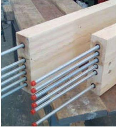
Figur 48 Protese som reparasjonsmetode i enden av bjelker. Her tres protesen på og stengene limes fast. Stålet er rustfritt. Hentet fra Corradi et al. (2019)
