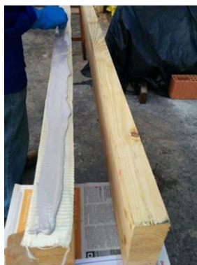
Figur 25 Påføring av lim før bruk av FRP (Fiberforsterket polymerer) som forsterkningsmetode. I høy grad ikke-reversibelt da det er svært vanskelig å skille lim og trevirke/FRP etter herding uten at det skaper skader på materialene.. Bilde hentet fra Donadon et al. (2020)
