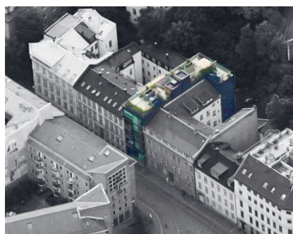
Figur 13-5 Innfylling – en ny bygning i Parkveien 5 B–C (ferdigstilt i 2011); To foto øverst: © Oslo kommune, Plan- og bygningssetaten. Gjengitt med tillatelse fra rettighetshaver. Foto nederst: © Blom.
