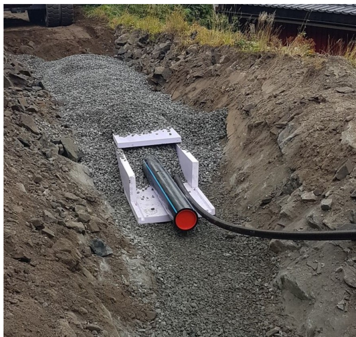
Figur 1.9: Røyrgroft med isolasjonsplater rundt røyret. Bilete frå Ringvegen, Vestby kommune. Foto: Inga Rise 2020
