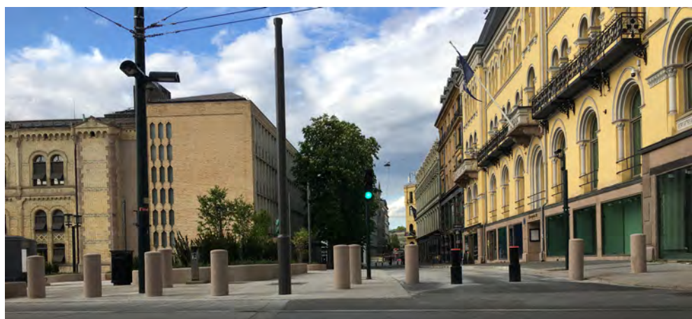
Figur 16. Bildet viser sikkerhetstiltakene på baksiden av stortingsbygget med blant annet kamera, blomsterkasser og andre sikringselementer (Abinaya A. Philip, 2020)
