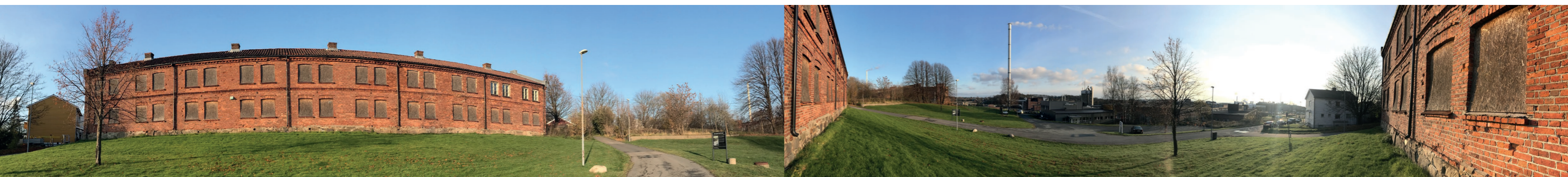
Fig 3.14. Panoramabilde av sørøstfasaden. Borregaardsveien vises på høyre side av bildet.
