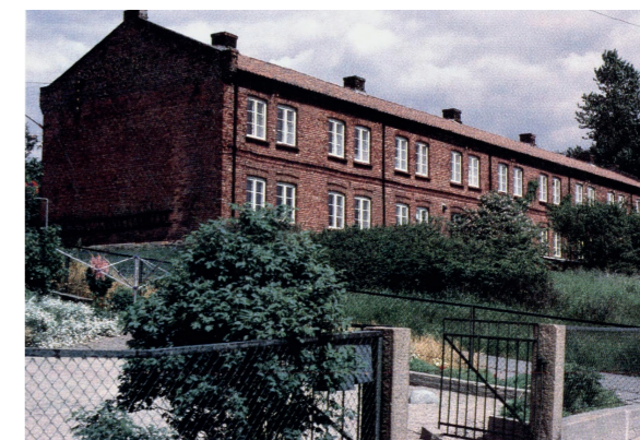
Fig 1.4. Da St. Olavs Vold ble bygget var Borregaard eid av det engelske firmaet Pelly & Co. Eierne av firmaet hentet inn engelsk ekspertise i byggingen. Dette er synlig i det karakteristiske engelske preget bygget har med teglfasade og brann gavler (Brantenberg, 1996, s. 115). Foto: Tore Brantenberg.
