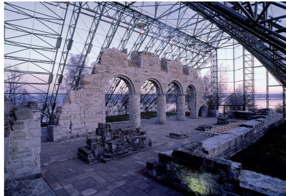
Fig 2.2. På Domkirkeodden i Hamar står ruiner fra en romansk katedral fra 1100-tallet. Denne ruinen har vært gjenstand for debatt knyttet til bygningsvern i Norge. Da det skulle bygges et modernistisk vernebygg i glass for å beskytte ruinen ble det igangsatt en underskriftskampanje for å stoppe prosjektet. De som var imot vernebygget, mente det stridde mot å bevare områdets autenticitet. Noen ytret at ruinen burde forfalle naturlig, andre mente katedralen burde restaureres og bygges opp på nytt. Av sikkerhetsmessige årsaker var det ikke mulig å la bygningen stå og forfalle uten et vernebygg, derfor ble resultatet at vernebygget ble reist. Bygningen ble imidlertid fort populær blant lokalbefolkningen, og er i dag en turistattraksjon (Christensen, 2011, s. 221-223). Foto: Domkirkeoddens fotoavdeling.
