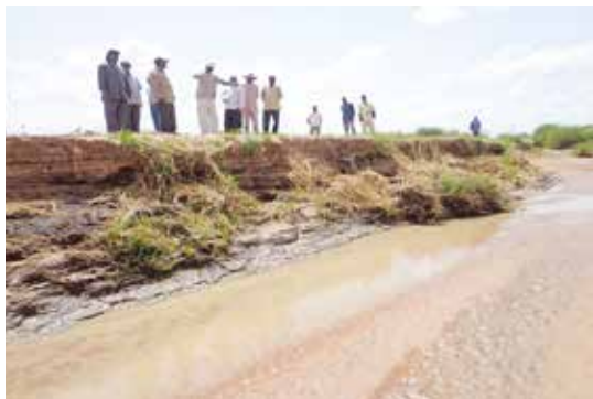
Photo 2 : Ravinement des berges à Babassangué. Action du passage des eaux collinaires, juillet 2013, lors de la visite de terrain du Directeur Général de l'IER
