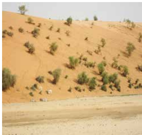
Photo 10 : Fixation biologique des dunes pour contraindre l'avancement du sable
